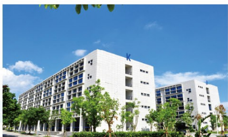
科研实训大楼
